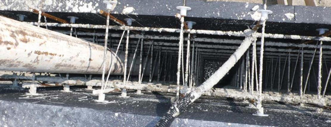
Si demandé par la hauteur du coulage en béton, utiliser des tubes afin de le réduire
