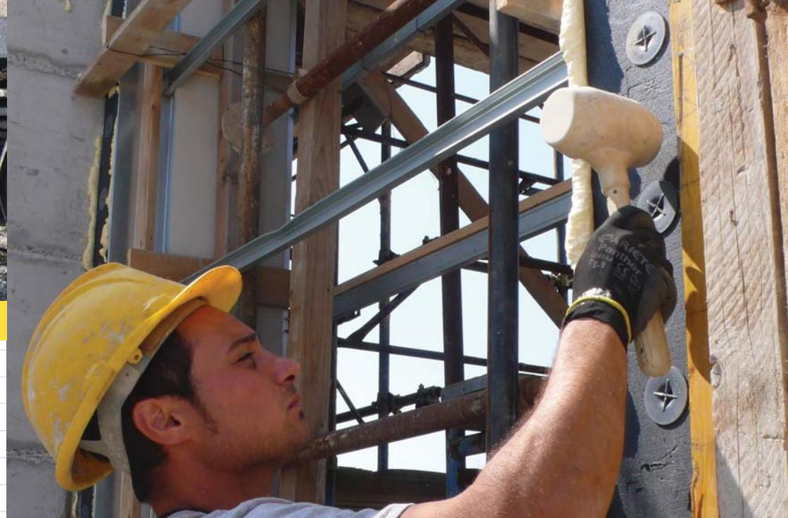
Taper sur les coffrages Wall Plastbau® 3 avec une plaque en bois et un marteau en caoutchouc tandis que le coulage monte
