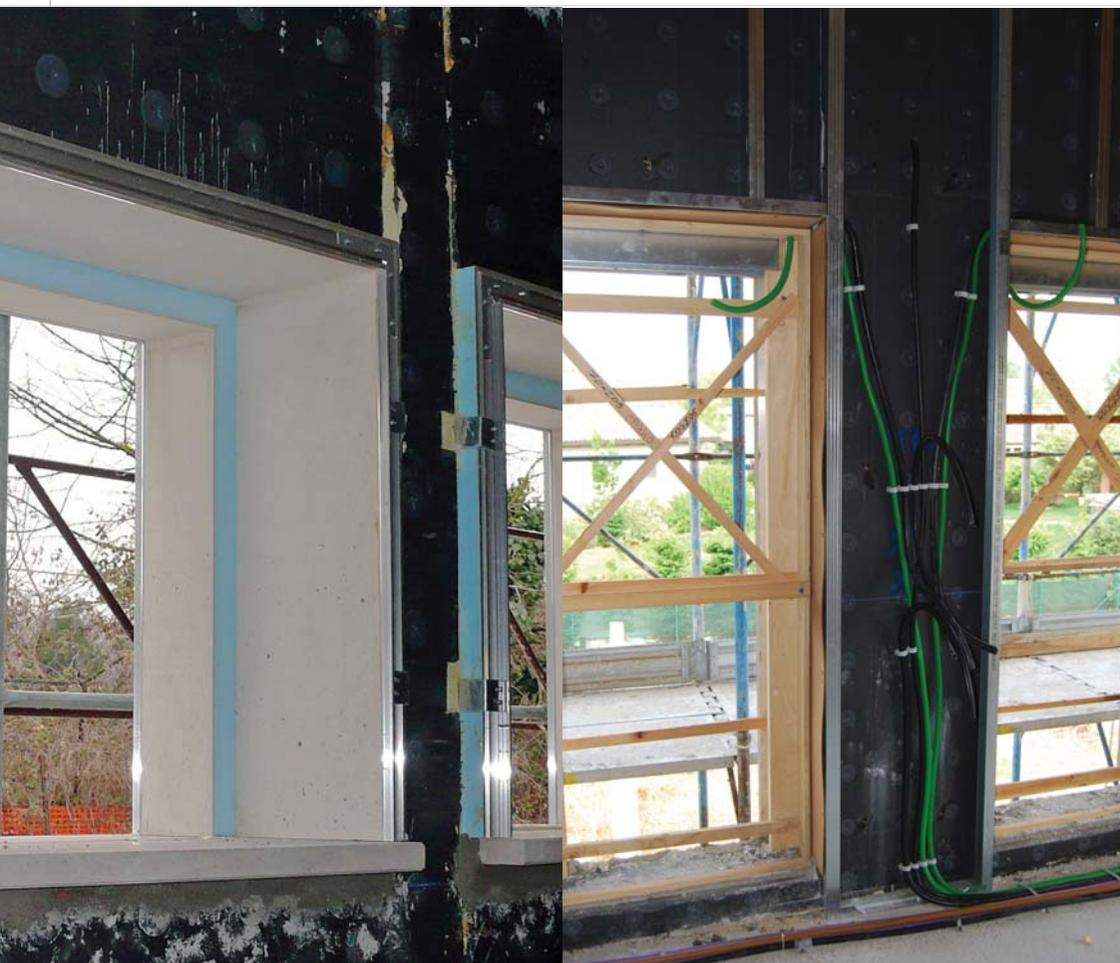
Faux-cadre préfabriqué à assembler avant le coulage
