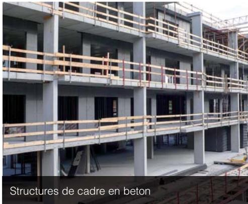
Structures de cadre en béton
