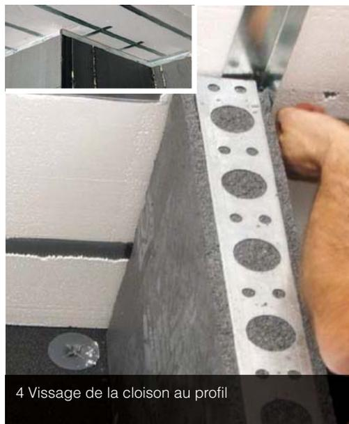
4 Vissage de la cloison au profil
