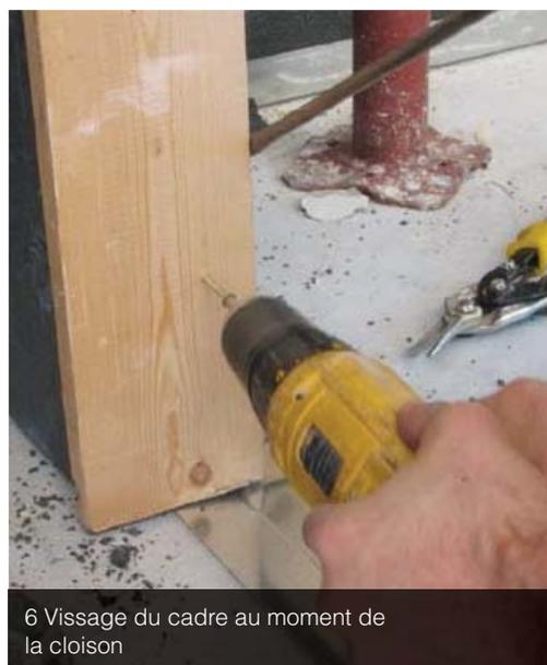
6 Vissage du cadre au moment de la cloison
