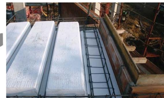
**POLIARMO** permet aussi d'obtenir des plaque droites avec des bords parfaitement parallèles et d'éliminer presque entièrement les gaspillages, car il est possible de juxtaposer une plaque à l'autre jusqu'à la longueur désirée. Avec le coffrage dalle **Plastbau® Metal**, il permet d'éliminer les ponts thermiques de la dalle au niveau des poutres.
