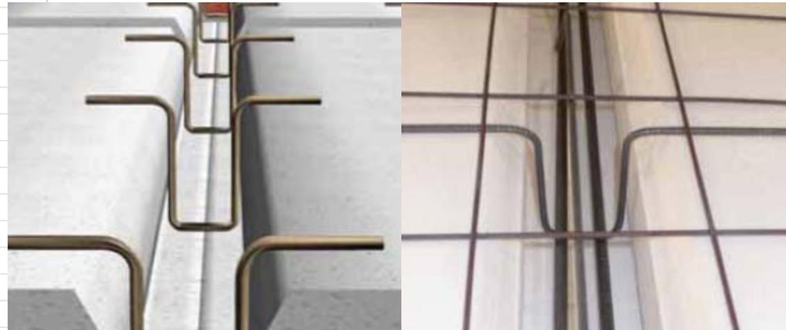
Les étriers Ø6 réalisées sur mesure et positionnés au niveau des solives de la dalle avant le coulage en œuvre pas 150 cm soutiennent les fers inférieurs en les séparant du fond du panneau et en garantissant un cache-poutrelles minimum.
