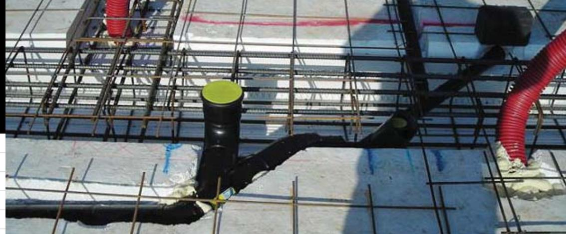
Les solives en acier **Plastbau® Metal** prévues pour l'intrados au-delà du support du faux plafond peuvent soutenir directement les installations, les barres porte-tubes ou les bandes des tuyaux supportées par les barres.
